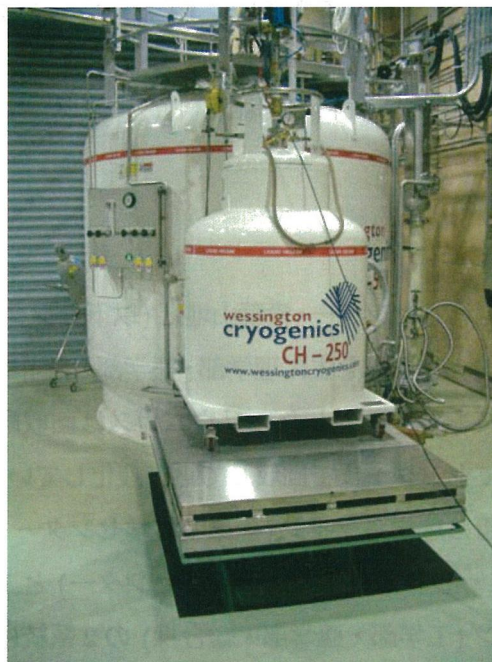
図4. 液体ヘリウム汲み出し作業。5000 ℓ 貯槽から250 ℓ 容器に小分けしている。テーブルリフトの天板にはロードセルが取り付けられている。
