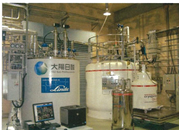
図 1. 片平地区の新ヘリウム液化機と 50000 l 貯槽の写真。
