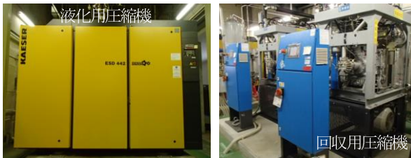
図3 極低温物理学部で稼働中の液化機（上図）と液化用、回収用圧縮機（下図）
