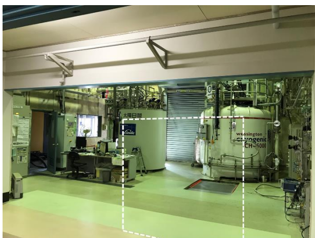
図1 ヘリウム液化室壁撤去工事(点線:元タドアがあった場所)
