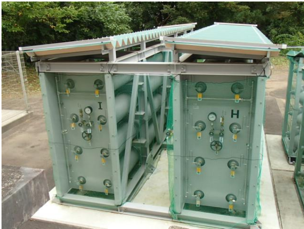
図3 増設したヘリウムガス長尺カードル2基
