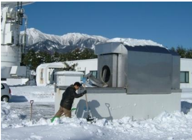
図 5. 野辺山電波観測所に設置したミリ波ボロメトリック天体干渉計試験観測施設。
