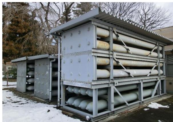
図4 回収ガス長尺カードル群
