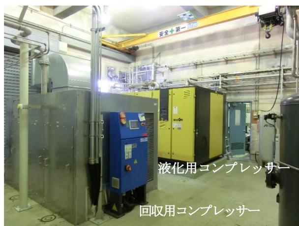
図2 低温科学部3代目ヘリウム液化機（上図）と液化用、回収用コンプレッサー（下図）
