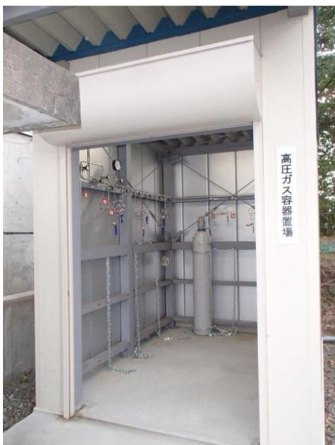
図4 新設したヘリウムガスボンベ庫
