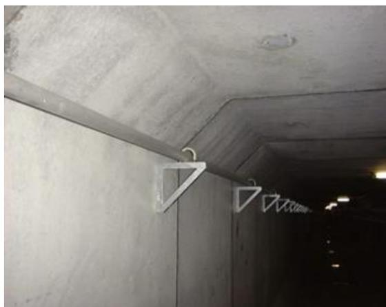
共同溝内のヘリウムガス回収配管
