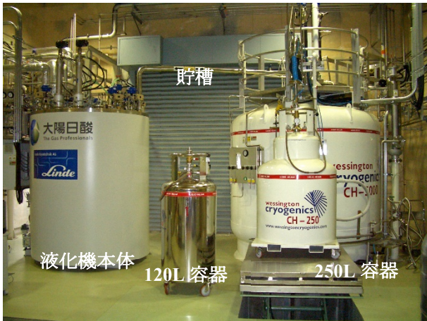
図9 リンデ社製 200L ヘリウム液化機 (写真：東北大学極低温科学センター蔵)
