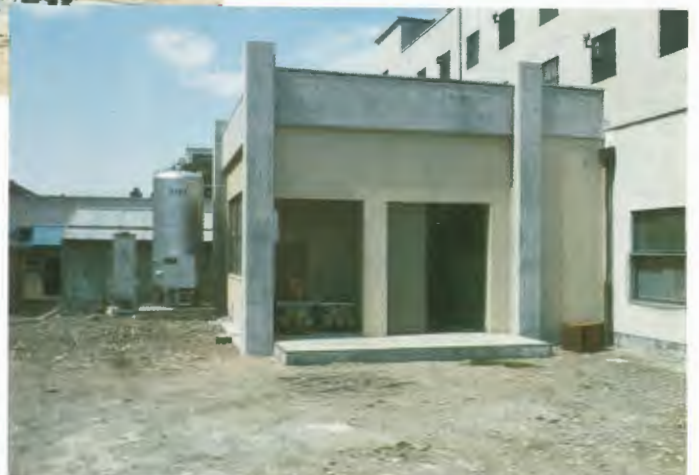
電気通信研究所サブセンター全景
